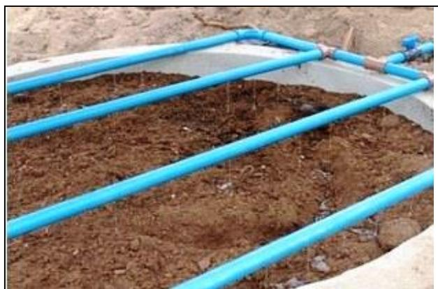
**Figura 41:** Tubulação de chegada com diferença de diâmetro do tubo de abastecimento do garfo no filtro biológico e registro instalado.
