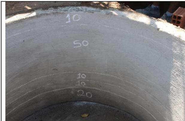
**Figura 23:** Marcação das camadas no filtro biológico do bioágua
