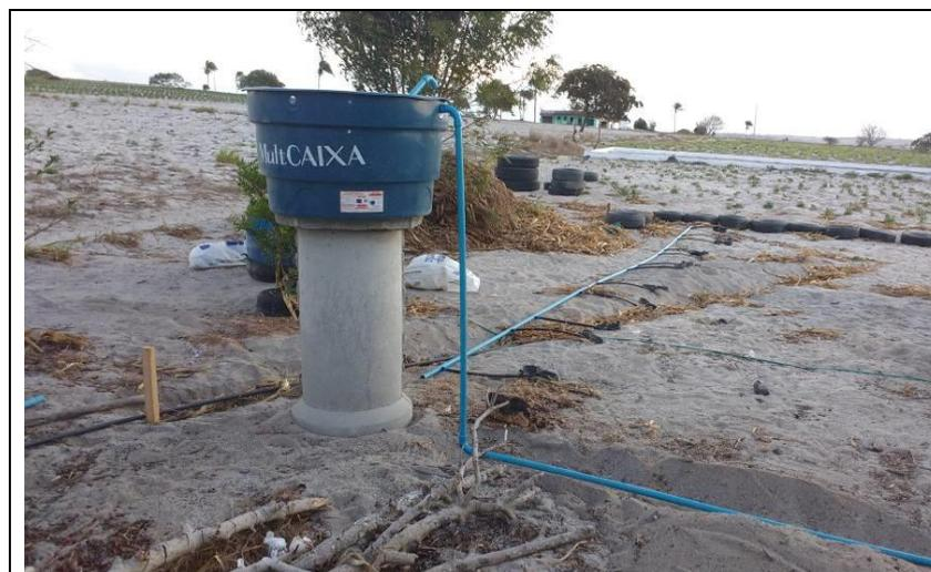
**Figura 42:** Caixa d'água do Sistema de Bioágua sob manilha. Ao fundo, linha principal de irrigação de onde saem as linhas de gotejamento do sistema de irrigação.
