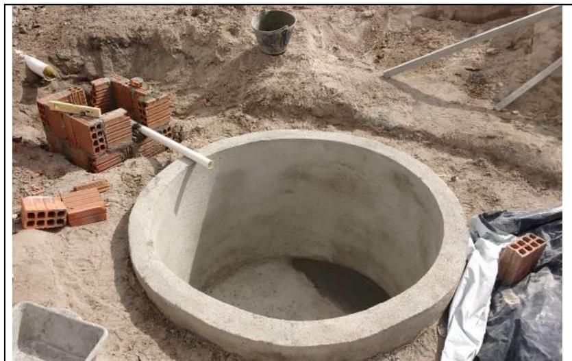
**Figura 37:** Detalhe de tubulação de chegada com diferença de diâmetro (tubo de 100) e tubo de abastecimento do garfo no filtro biológico (cano de 50).
