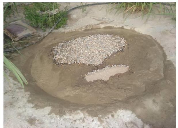
**Figura 9:** Adição de brita à mistura de cimento e areia. A água deve ser bem dosada e o local de execução da massa deve estar limpo.
