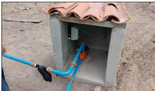
**Figura 38:** Detalhe da instalação de saída da bomba – ligação do filtro de disco.
