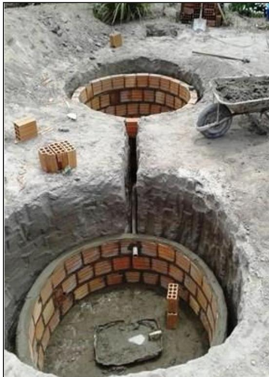
**Figura 16:** Execução e alvenaria circular dos tanques (filtro biológico e tanque de reuso)
