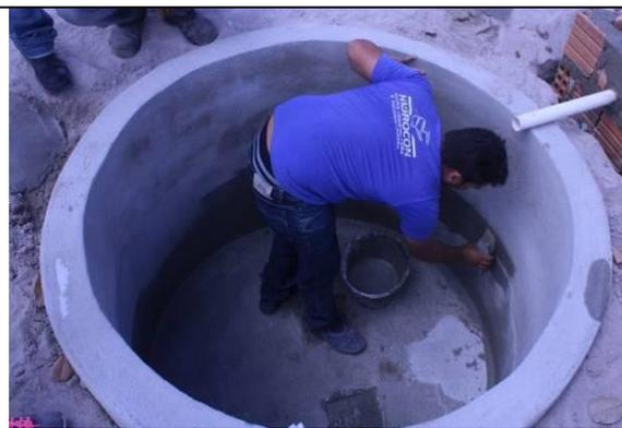
Figura 19: Aplicação de impermeabilizante hidrofugante - vedacit.
