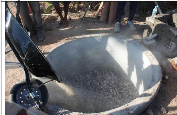
**Figura 25:** Camada de 10cm de brita do filtro biológico do bioágua
