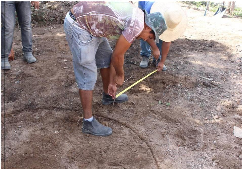
**Figura 1:** Locação dos pontos de escavação dos tanques do Sistema – execução da circunferência utilizando o compasso de obra.
