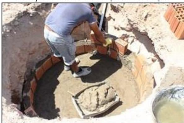
**Figura 13:** Elevação das fiadas de alvenaria
