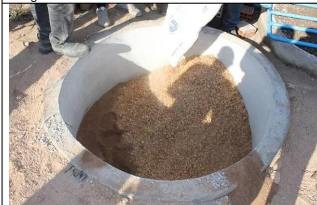
**Figura 27:** Camada de 50 cm de serragem do filtro biológico
