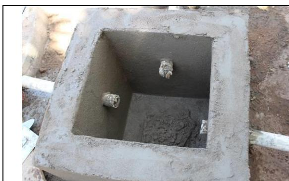
**Figura 21:** Caixa de gordura com tubulações conectadas. (esquerda) e ao lado a caixa de gordura rebocada (direita).
