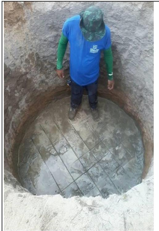
**Figura 10:** Execução da base dos tanques para posterior elevação de paredes.
