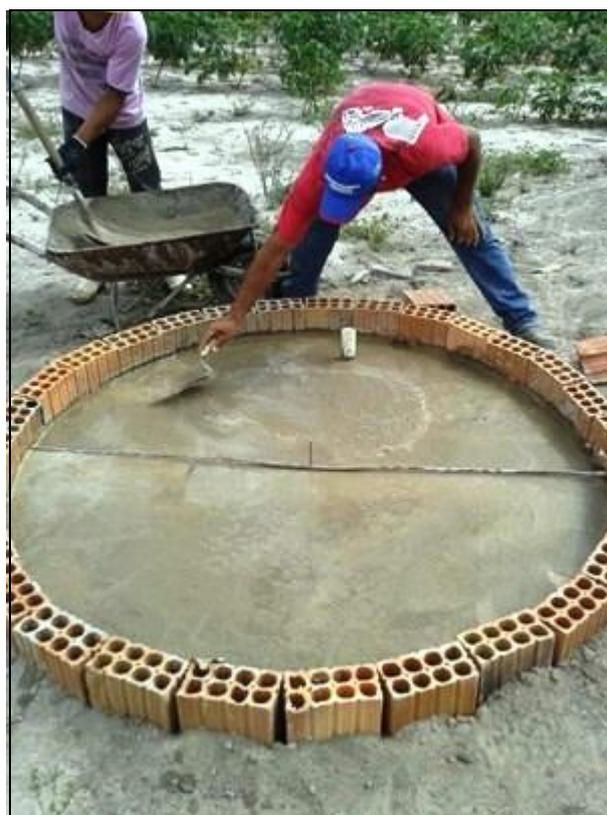
Figura 4: Exemplo de forma para laje de tampa do tanque de reuso do sistema.
