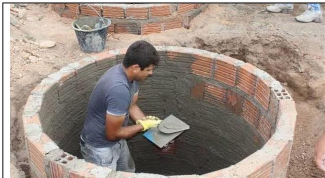
Figura 17: Execução do chapisco no tanque
