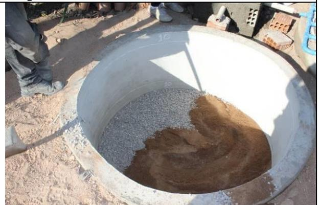
**Figura 26:** Camada de 10cm de areia lavada do filtro biológico do bioágua
