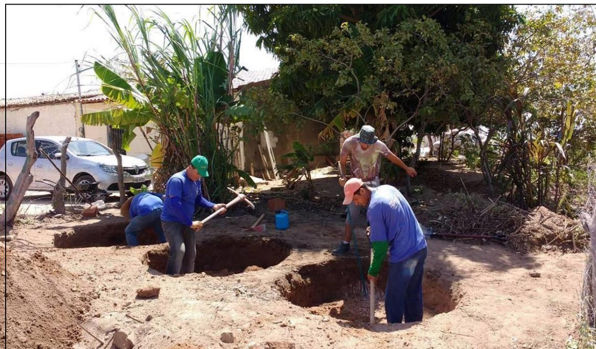
**Figura 2:** Proximidade do Sistema às residências e a possibilidade de construção do sistema dentro do cercado do quintal produtivo. Escavação manual dos buracos para os filtros do sistema.
