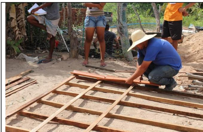
**Figura 30:** Detalhe de montagem do engradamento, utilizando as telhas como gabarito
