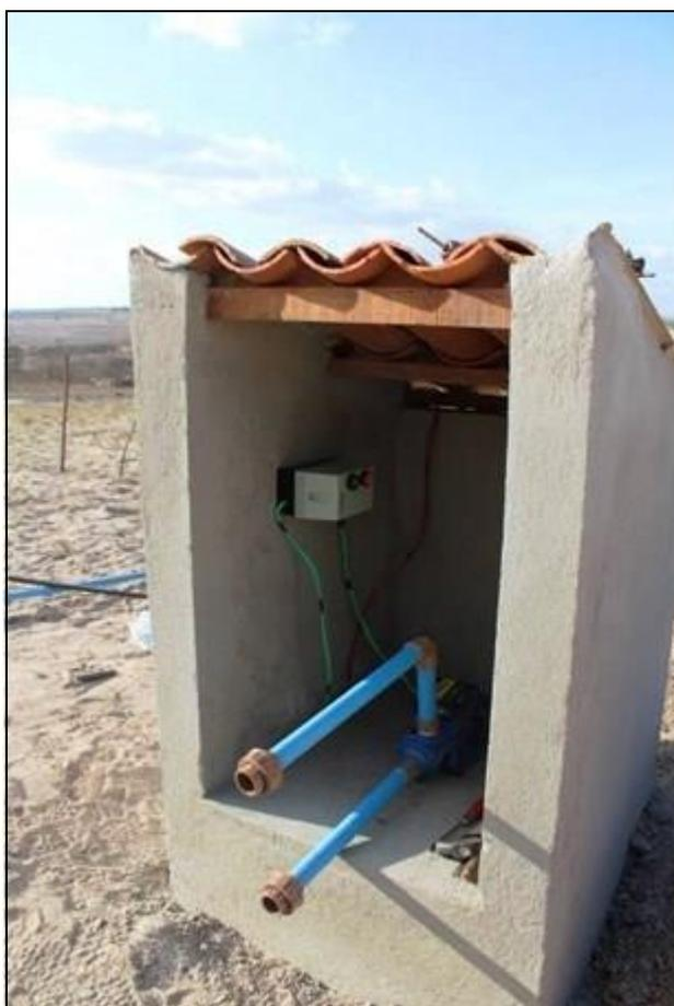
**Figura 36:** Instalação elétrica - Sistema de Bioágua. Dentro da casa da motobomba, detalhe da caixa de energia.
