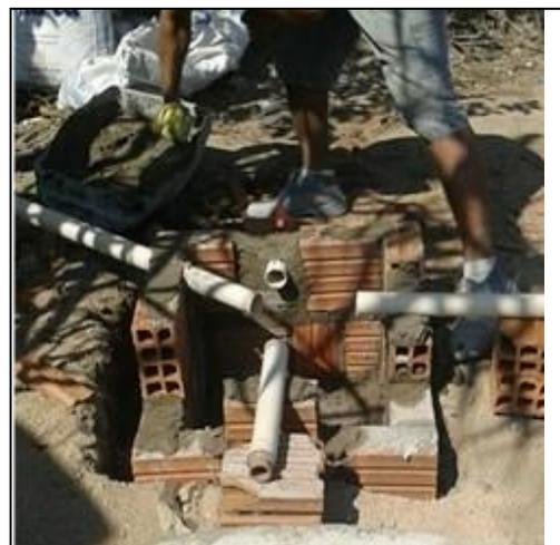
**Figura 20:** Execução da caixa de gordura elevada em alvenaria com tubulações de chegada e saída conectadas.
